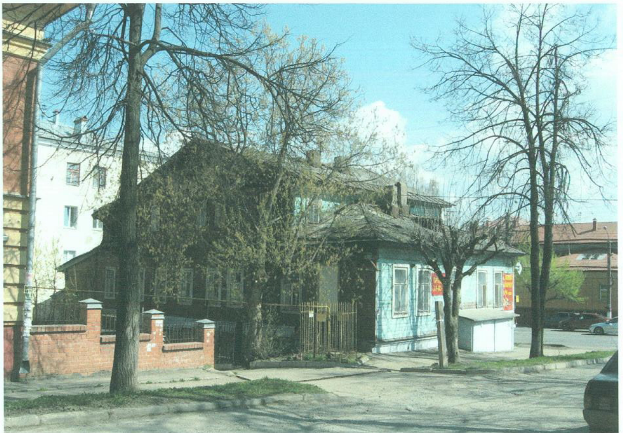
Фото 4. Общий вид с юго-запада, с улицы Пятницкой.
