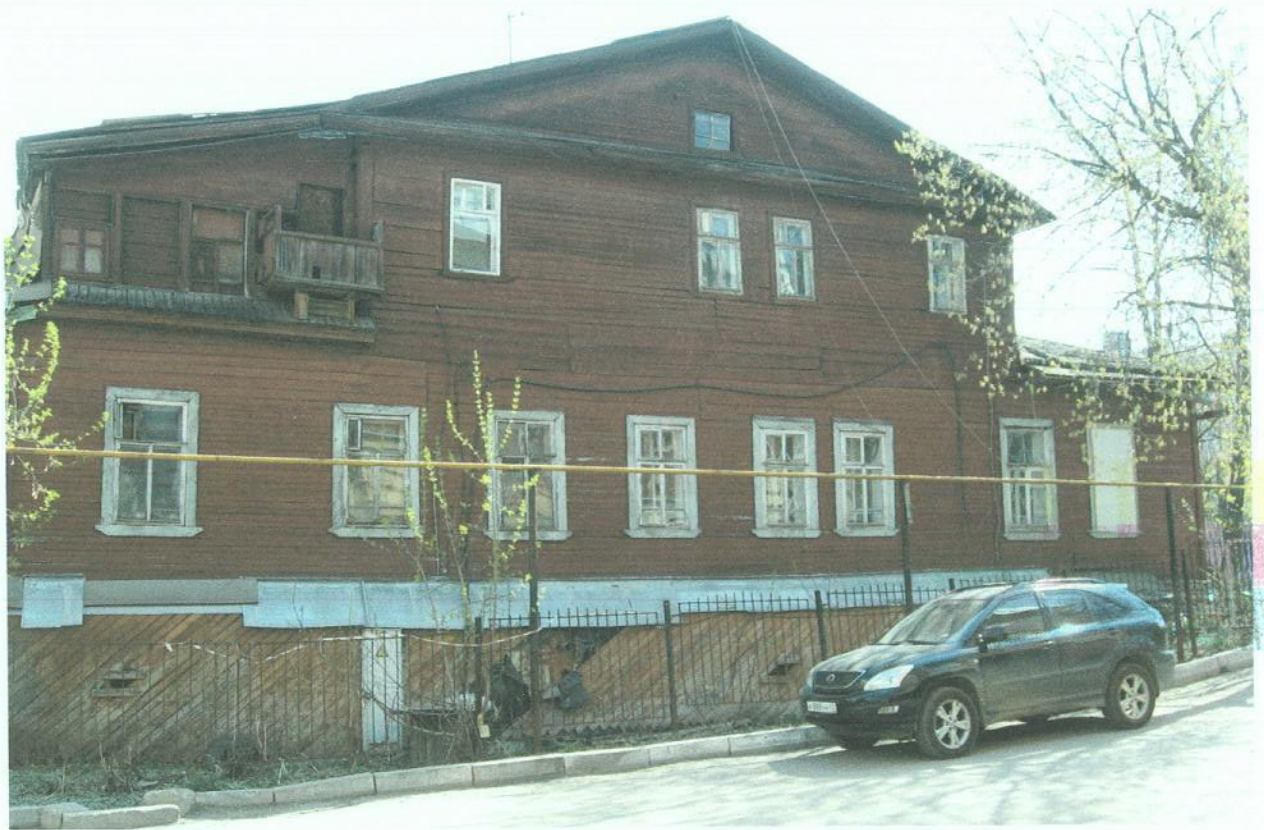
Фото 7. Западный дворовый фасад.
